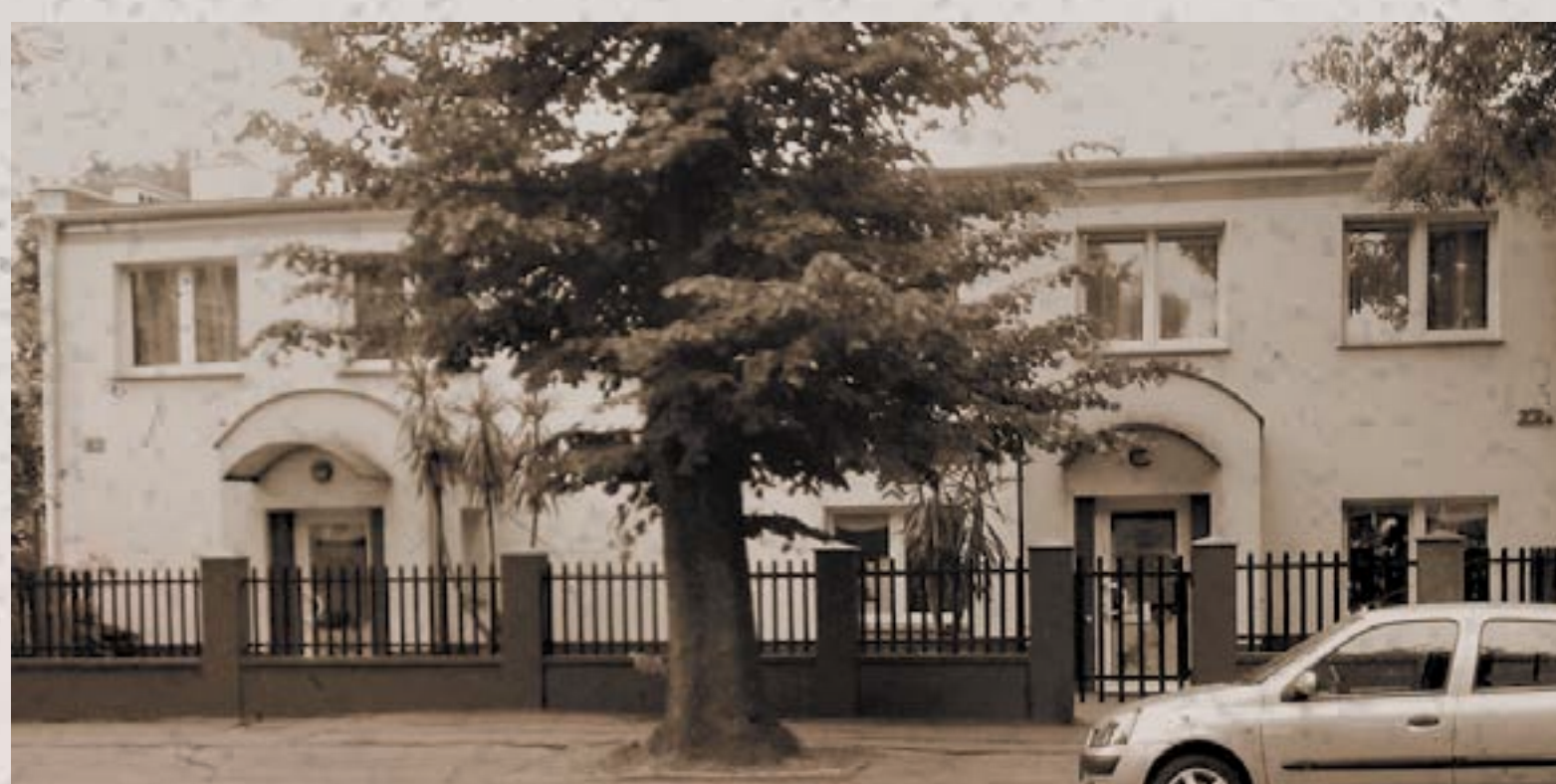
Siedziba Wojewódzkiego Urzędu Statystycznego w Legnicy, ul. Grunwaldzka 22 – 1975 r.
