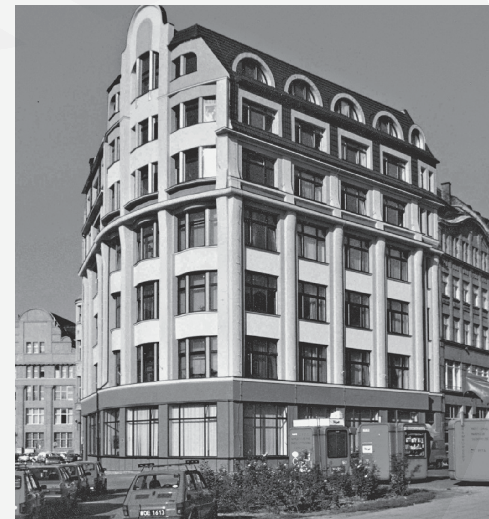
ul. Oławska 31. Budynek po nadbudowie oraz wykonaniu elewacji wraz z kolorystyką – 1996 r.
