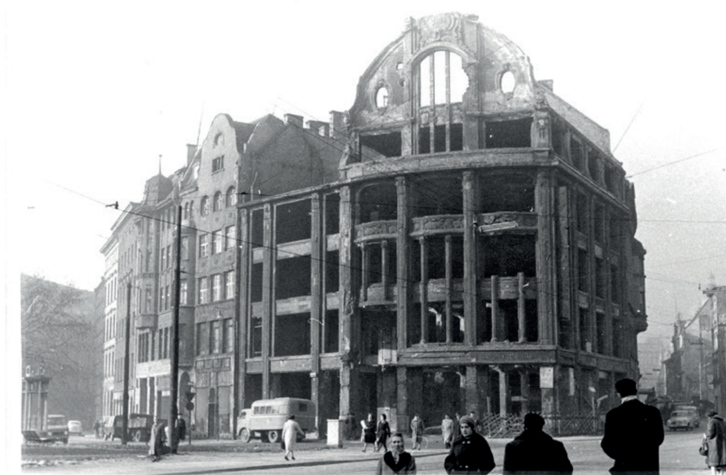
Stan zniszczeń wojennych (1960 r.) – późniejsza siedziba WUS, MUS i WSTS
